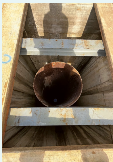
Vue de l'intérieur d'une cave de forage avec son tube guide.
