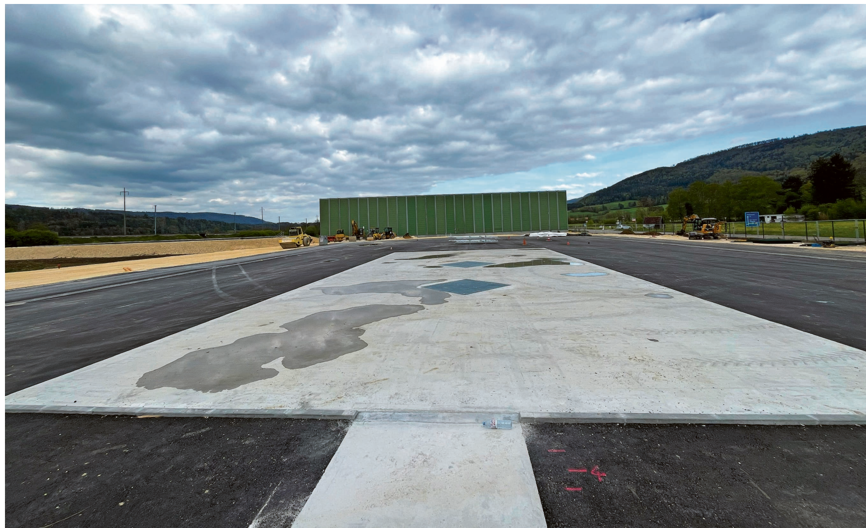
Vue de la place de forage avec la paroi antibruit en arrière-plan.
