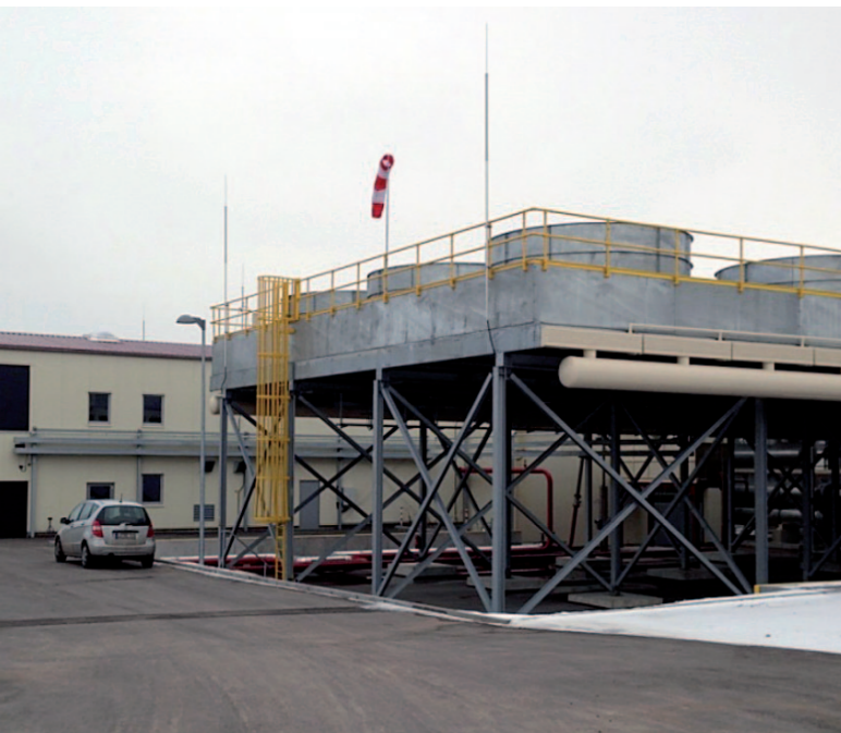
Le bâtiment d'exploitation et les aéro-refroidisseurs de la centrale géothermique d'Innsheim, en Allemagne
